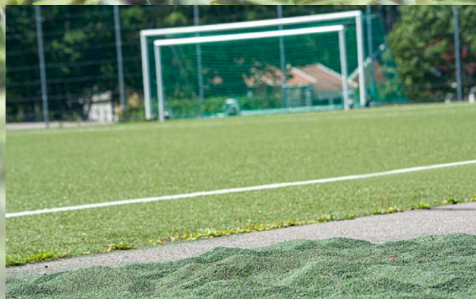
Allvädersplaner består ofta av fyllning av gummigranulat som ska göra planerna mer hållbara och vädertåliga samt dämpa stötar.
