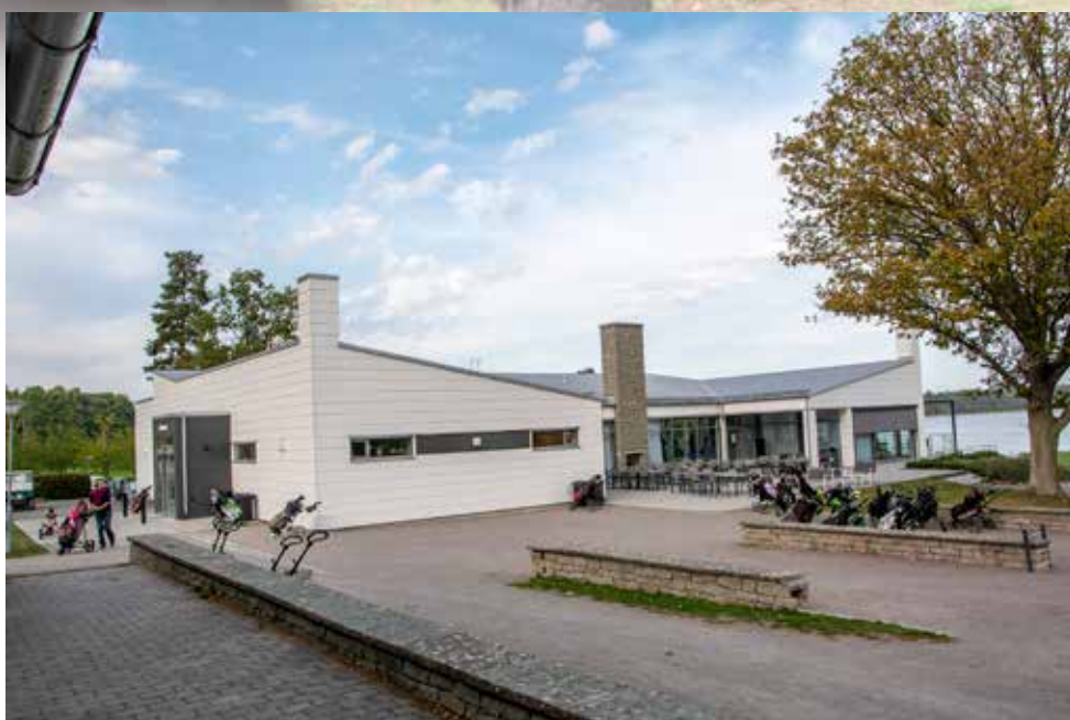
I juni 2017 invigdes det nya klubbhuset där större delen av markjobbet utfördes i egen regi.
